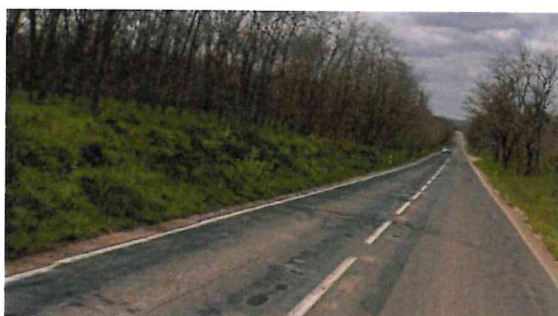
Mozaikové a příčné trhliny, hloubková koroze
