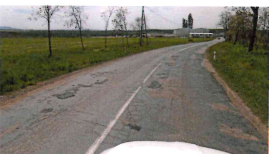
Síťové trhliny, plošné deformace, vysprávký
