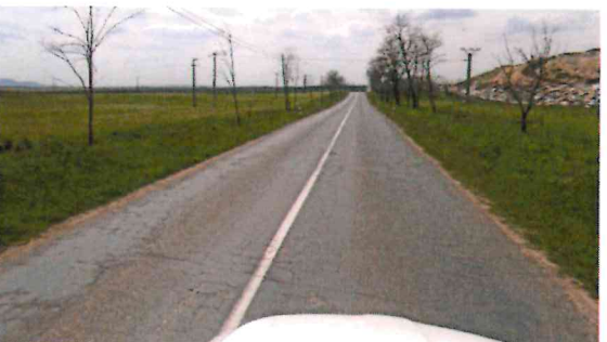
Mozaikové a příčné trhliny, zvýšené nezp. krajnice
