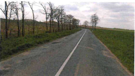
Příčné trhliny, hlubková koroze, vysprávký
