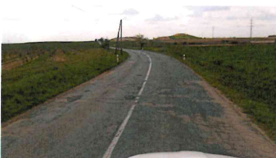
Síťové trhliny, plošné deformace, vysprávký
