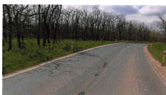
Vysprávký, zvýšené nezp. krajnice, pod. a příč. trhliny
