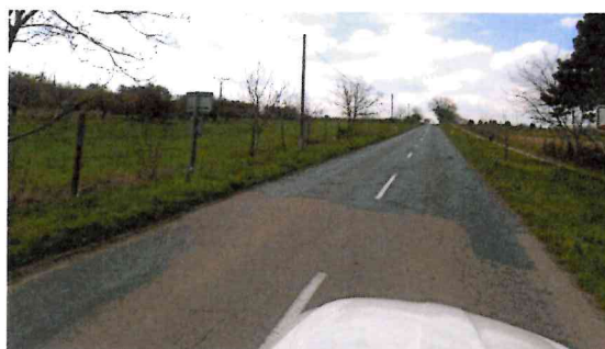
Mozaikové a podélné trhliny, vysprávký
