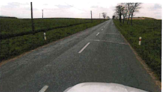
Vysprávký, moz. trhliny, zvýšené nezp. krajnice
